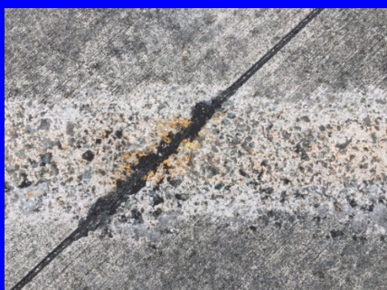
◇従来切削機の仕上り (黄線消去)
