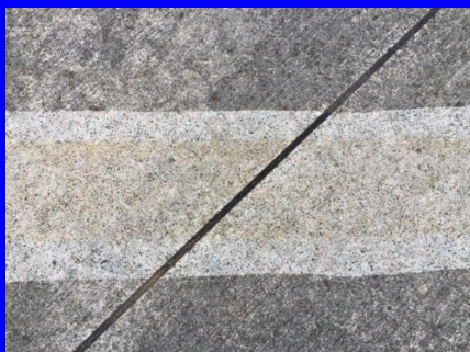
◇ウォータージェット工の仕上り (黄線消去)
